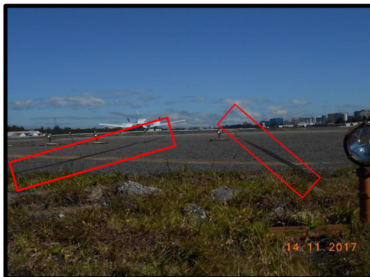
Fotografía No. 24 La doble marca de frenado al final de la pista.
